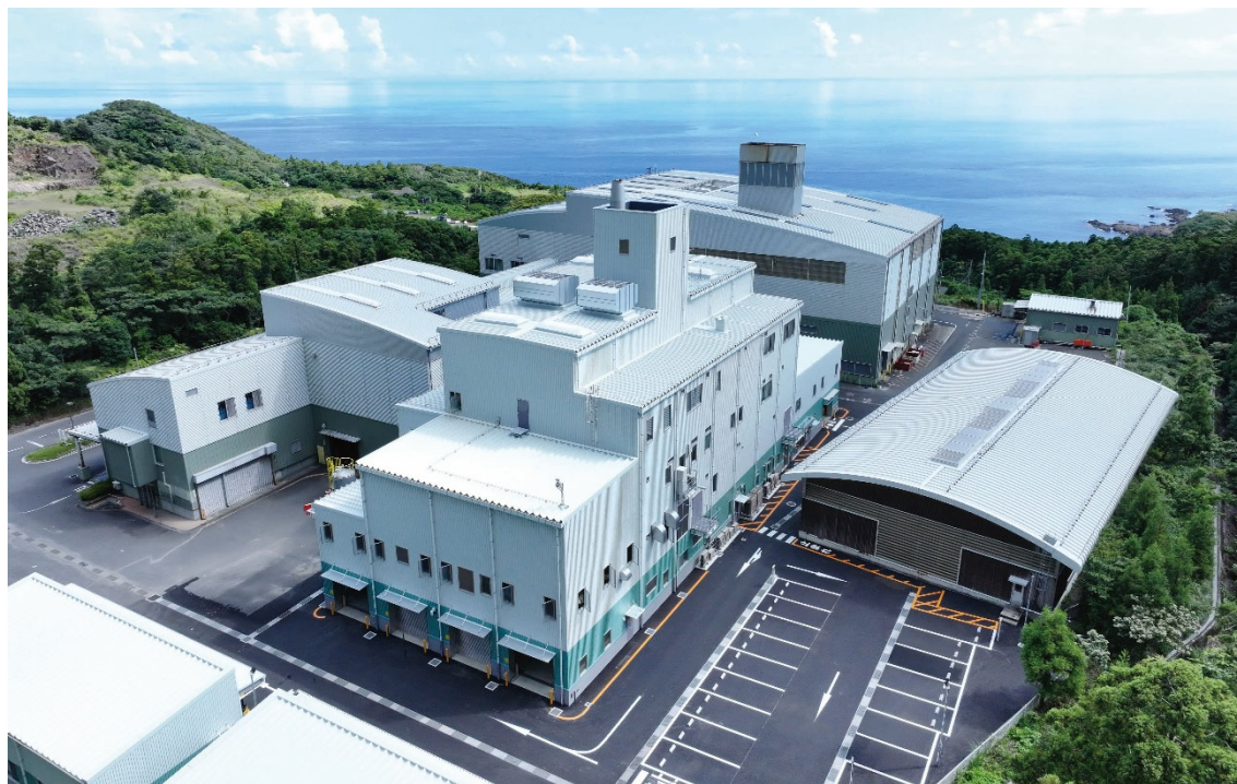
施設外観（写真中央部：新ごみ処理施設、写真左下：段ボール処理棟・発泡スチロール処理棟）
